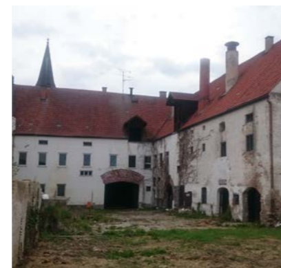
Gabelsberger Straße 2 - ehem. Brauerei Brunner
