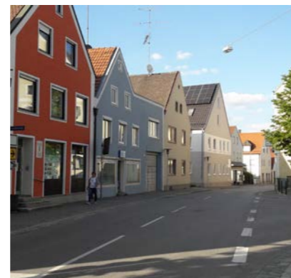
4 - ehem. Geschäftshäuser Marktplatz
