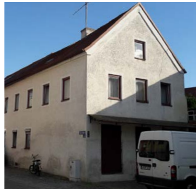
Bachstraße 2 - ehem. Geschäfts- und Wohnhaus
