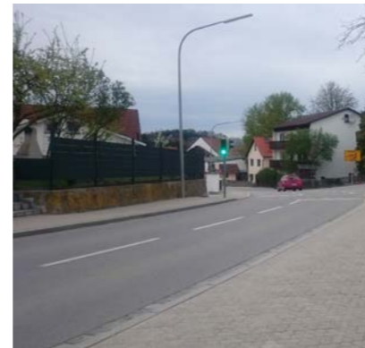
2 - Moosburger Straße mit Asphalt und Betonpflaster
